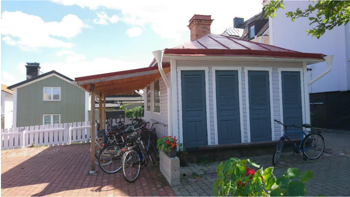
Norra fasaden med skärmtak och västra med de gamla dassdörrarna med jalusifyllnader.
