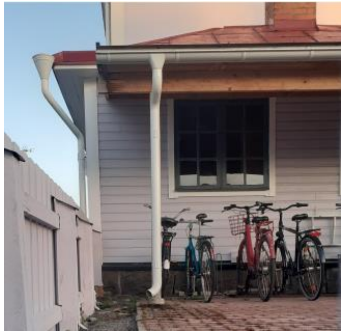
T.v. Norra fasaden från andra hållet. T.h. de småspröjsade fönstren som troligen är original. Skärmtaket har hänggränna och stuprör i samma kulör som huset. Foto: Atrio
