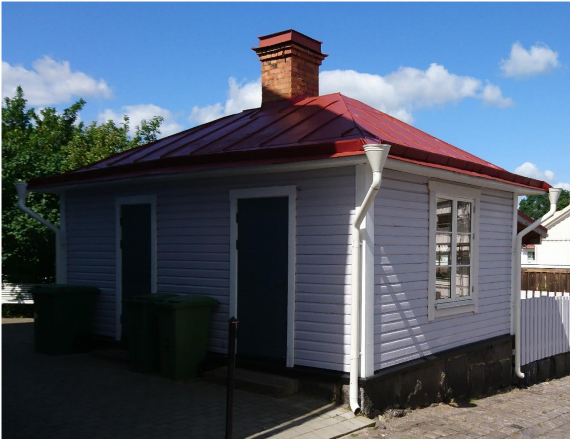
På bilden syns uthusets södra och östra fasad med nya dörrar och fönster.
