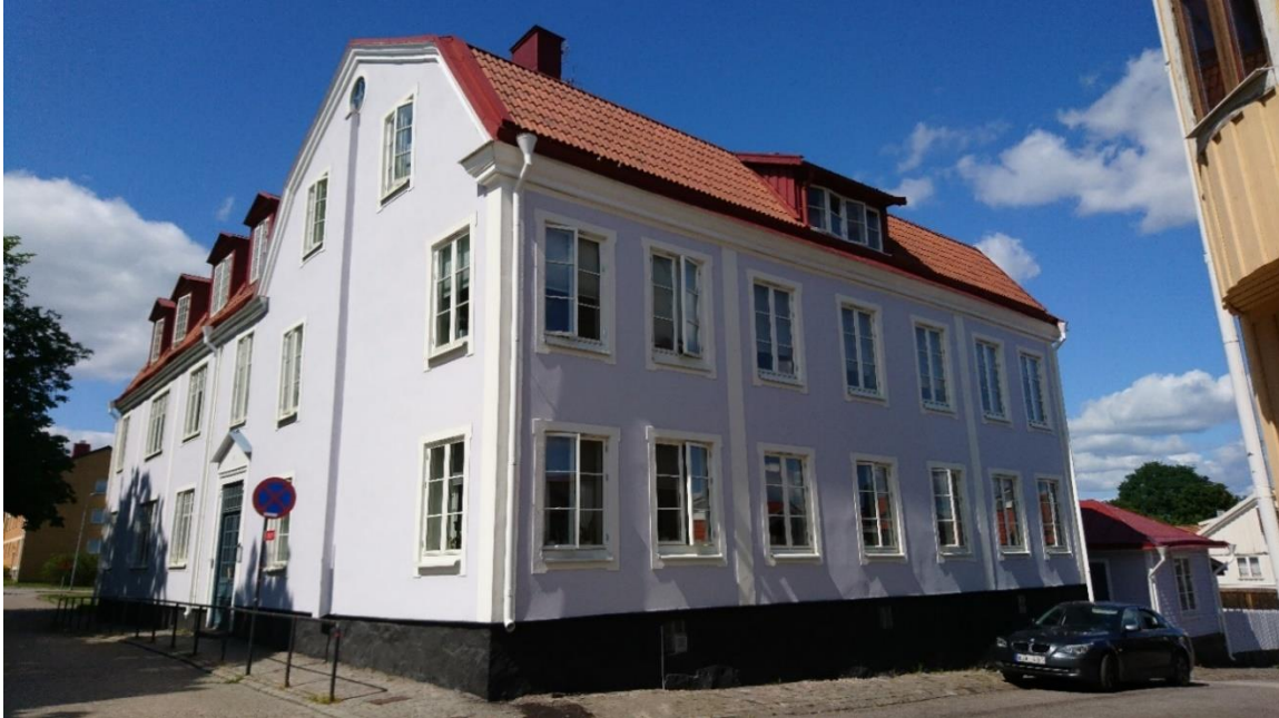
Fastigheten Stampen 1 fotograferad från det sydöstra hållet. Byggnadsdelen som är uppförd 1752.
