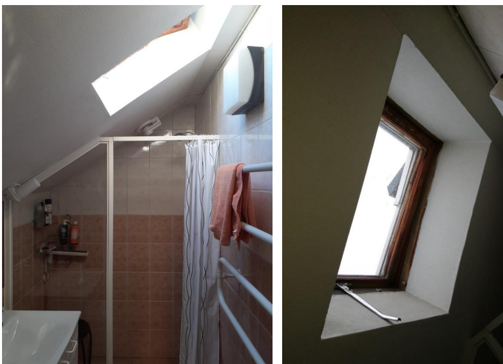
T.v. Inifrån badrummet. T.h. takfönstret i badrummet. Foto: Atrio
