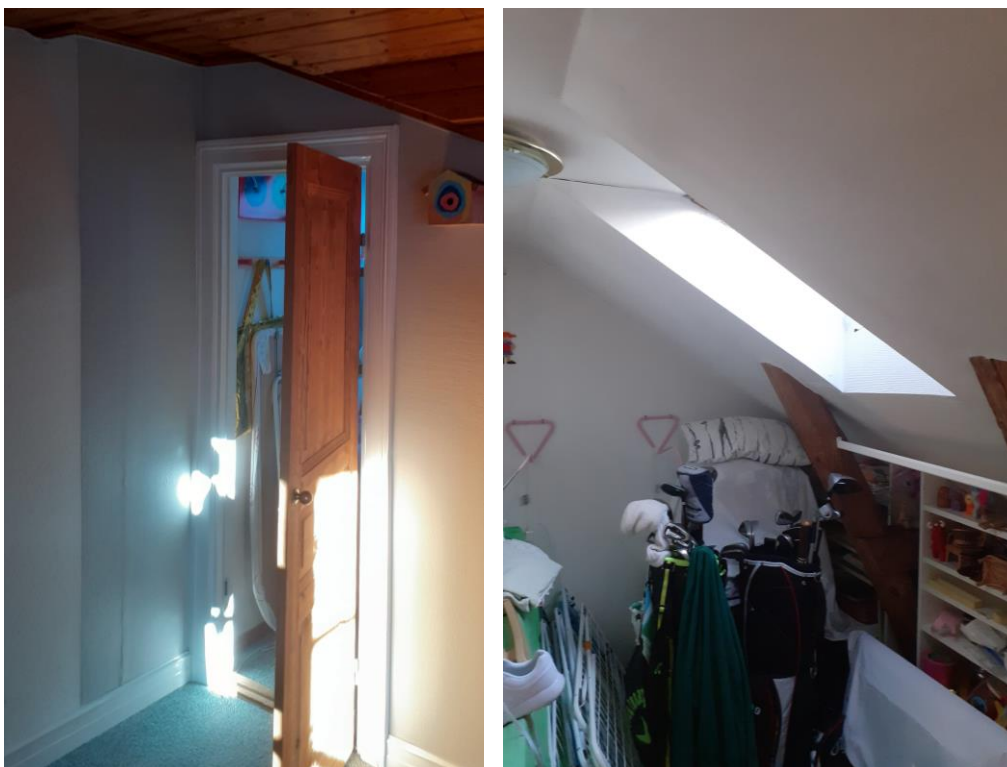
T.v. Dörr till syrum. T.h. Syrummet inifrån med delar av takstol och takfönster. Foto: Atrio
