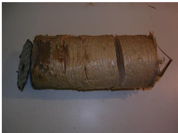
Borrkärna av ytterväggen under lastbryggan.
