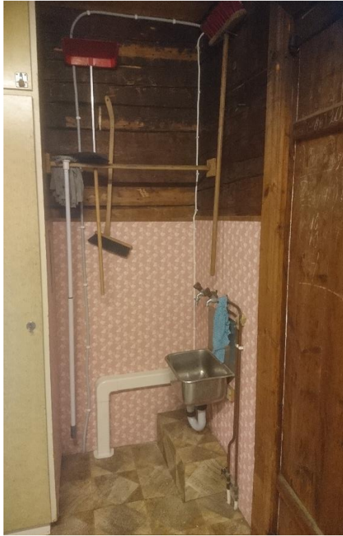
Före och efter rördragning mellan kök och kryputrymmet i städskrubben i ena hörnet av lagerlokalen/magasinet.
