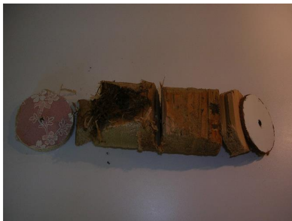
Borrkärna av äldre yttervägg mellan kök och magasin.
