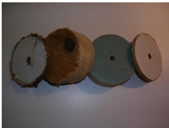
Borrkärnor mellan kök och kafédel. T.h. syns att de spontade brädornas not ligger mot varandra.
