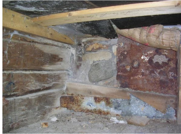
Bild tagen inifrån kryputrymmet på hörnet av den byggnadsdel som har naturstenssockel och som förlängts med en timrad del mot sydväst.
