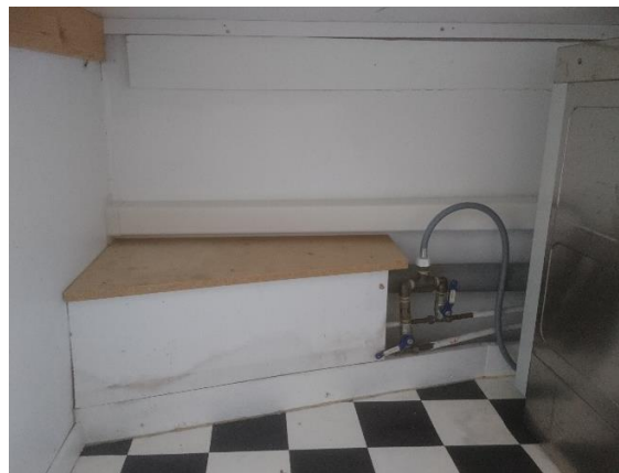
T.v. rördragning i köksskåp under diskbänk. Nedan före och efter rördragning bredvid diskmaskin under arbetsbänk.
