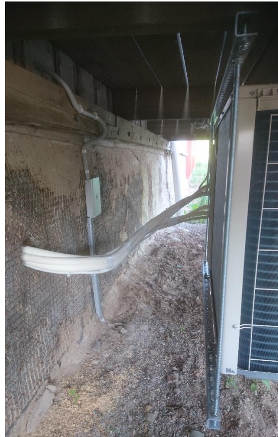
Före och efter rördragning i kryputrymmet under lagerlokal/magasin. Nedan utgång genom yttervägg till yttre del/ aggregat under lastbrygga.
