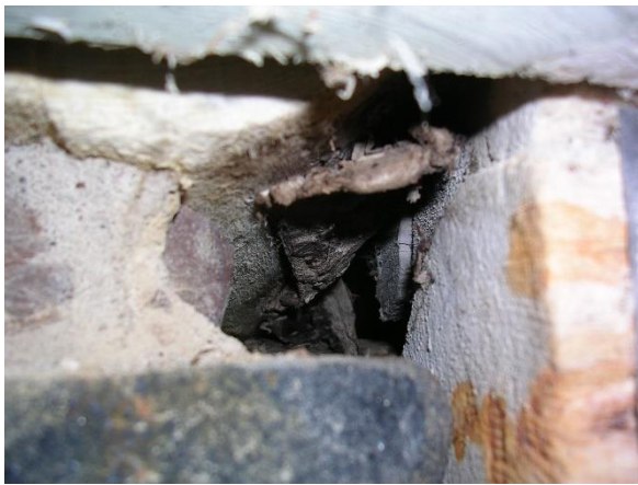
Närbild tagen utifrån, där de olika byggnadskropparna möts. I bildens övre del syns en del av det läder som fungerar som fuktspärr mellan stensockel och syll.
